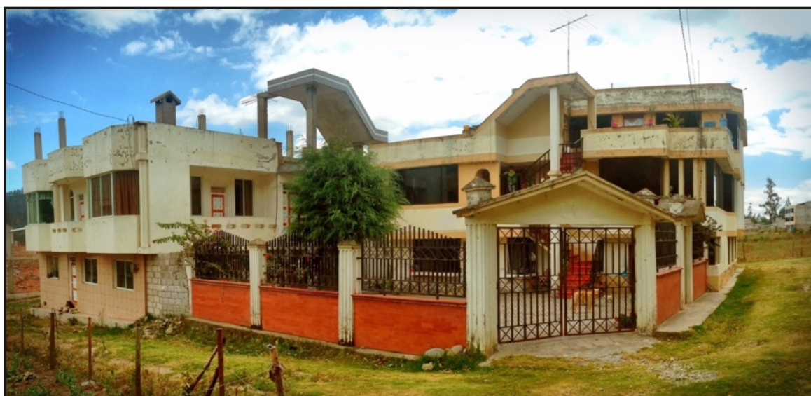
Fig. 25 – Maison de Mama María, où j’habite pour tous mes déplacements à Otavalo. La partie supérieure du bâtiment de gauche –appartenant à sa fille Liliana– comptait avoir un 3 e étage qui ne s’est jamais fait, laissant des poutres en pleine vue. Fakcha llakta, 2016
